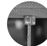
Serre-câble, sous le panneau permettant le réglage en hauteur
