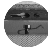
Die Verbindungsnoppe wird in die an der Decke angebrachte Schienenleiste eingeschoben
